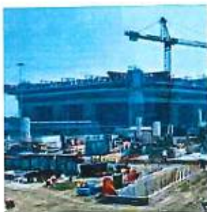
Cantiera M5 a San Siro (foto Lovelymilano.wordpress.com)
