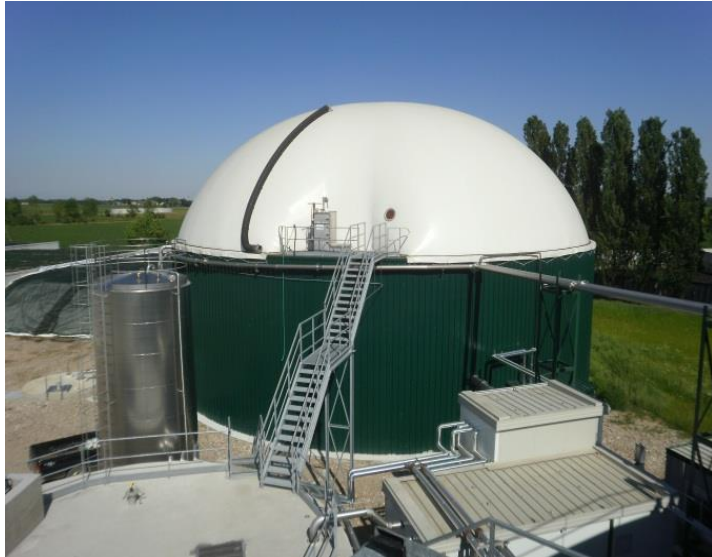
Impianto Digestione Anaerobica in piena scala con trattamento enzimatico
