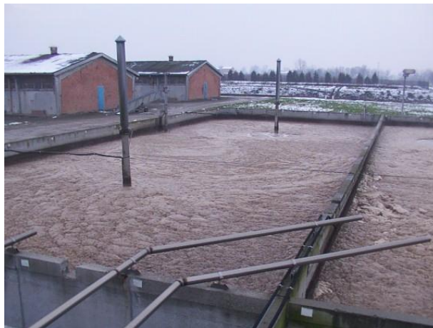
Impianto SBR c/o Allevamento S. Anna (MO)
