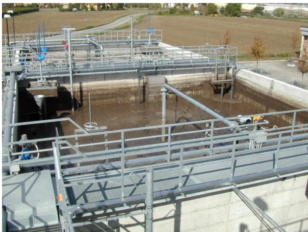
Impianto SBR di Funo di Argelato (BO)
