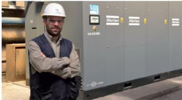
Cristian Bovo, Manutenzione, accanto al nuovo compressore a tecnologia Inverter installato presso lo stabilimento di Arcore, che consente una riduzione consistente dei consumi.
