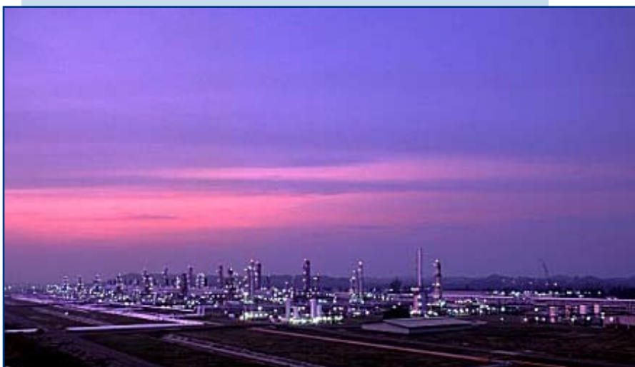
L'impianto di compressione e trattamento di gas naturale Lhoksumawe di Arun (Sumatra)
